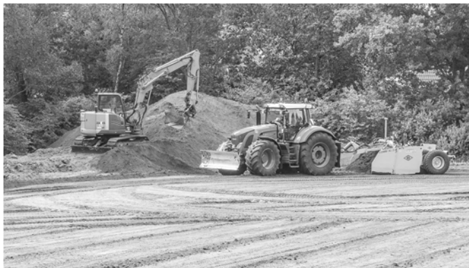
Efficiënt grond afgraven en verplaatsen met zwaar materieel
